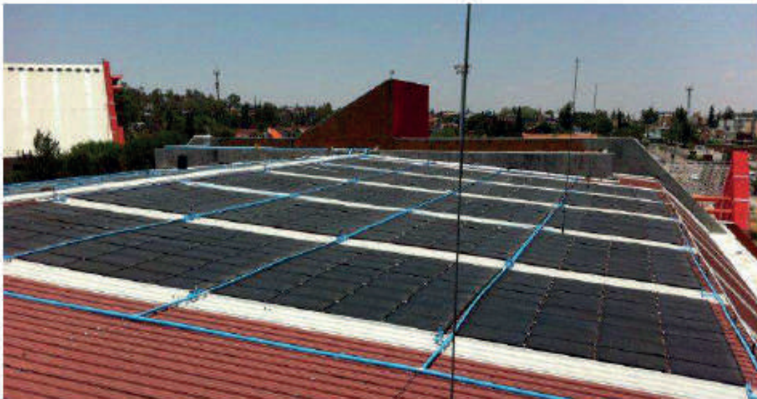
INSTALACIÓN DE 1,408 PANELES OKU® EN LA ALBERCA OLÍMPICA DEL IDEA (INSTITUTO DEL DEPORTE DE AGUASCALIENTES)
