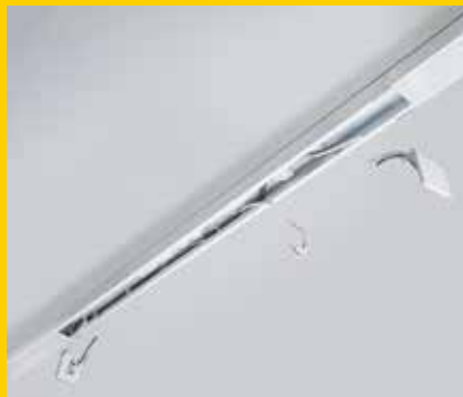
2. Remover las piezas finales y la conexión
